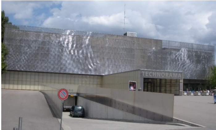
Rys. 6. Kinetyczna fasada Swiss Science Center Technorama (fot. Media-Flema); źródło: [CC BY 2.0 ( https://creativecommons.org/licenses/by/2.0/deed.en )], from Wikimedia Commons
