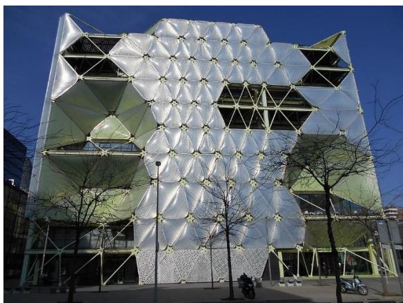
Rys. 1. Elewacja południowo-zachodnia budynku Media-TIC (fot. Canaan); źródło: [CC BY-SA 4.0 ( https://creativecommons.org/licenses/by-sa/4.0/deed.en )], from Wikimedia Commons
